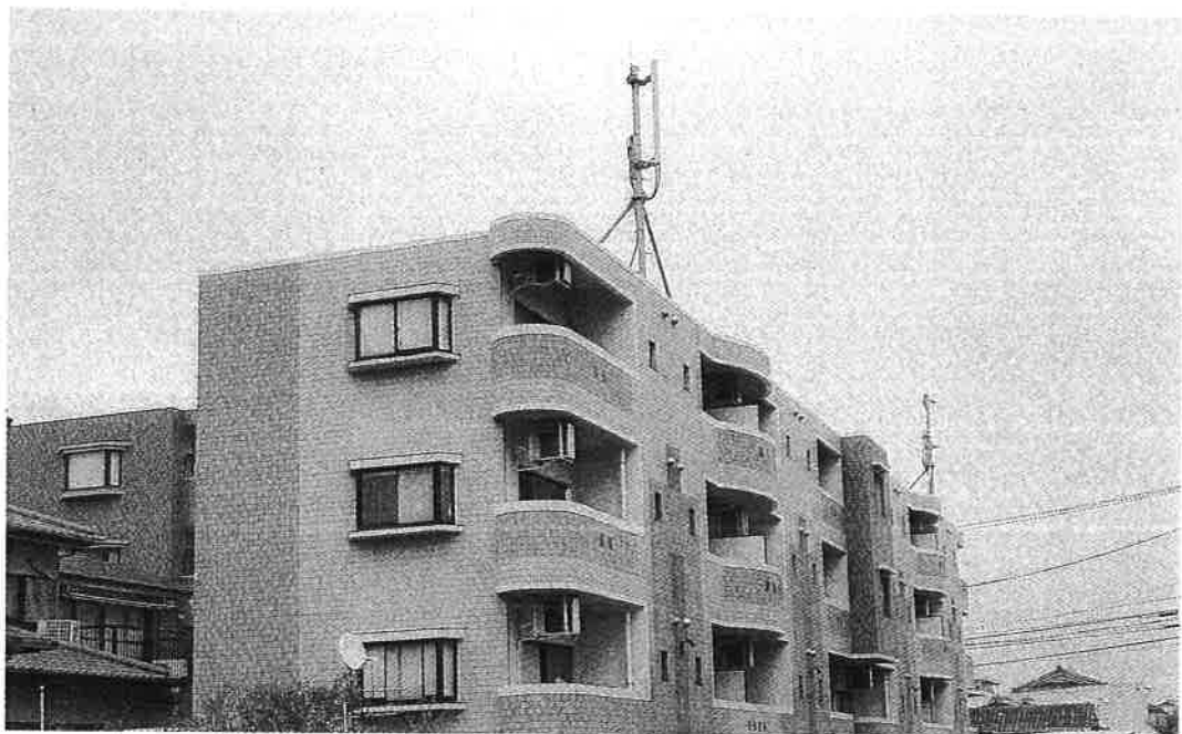
携帯基地局アンテナ
